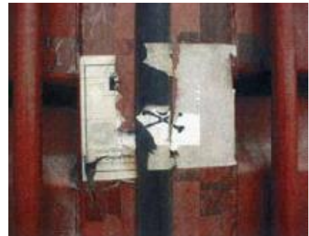
Segnale di avvertimento strappato
