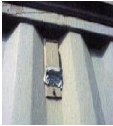
Fentes d'aération obturées
