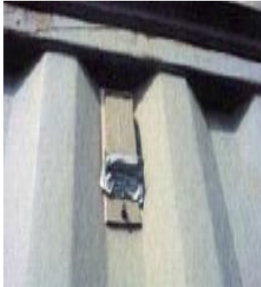
verklebte Lüftungsschlitze
