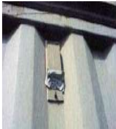
verklebte Lüftungsschlitze
