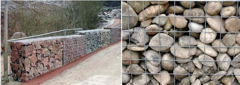
*Schlagwörter: Stützmauer / Lärmschutzmauer / Dammböschung / Gitterkorb / Drahtschotterkasten*
